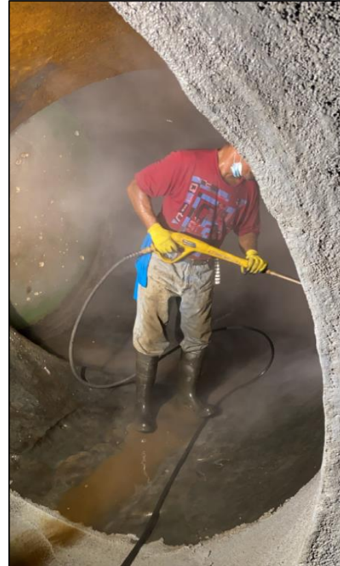
Preparación de la Superficie
