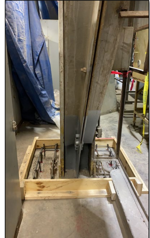
Fabricación de Columna
